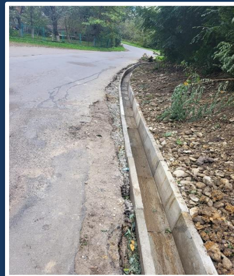
Монтаж збірних елементів (лотків) для водовідведення на вул. Церковна в с. Голинь
