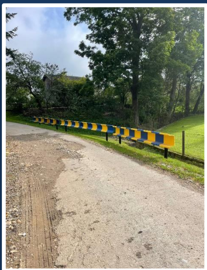
Поточний ремонт моста на вул. Шевченка в с. Вістова
