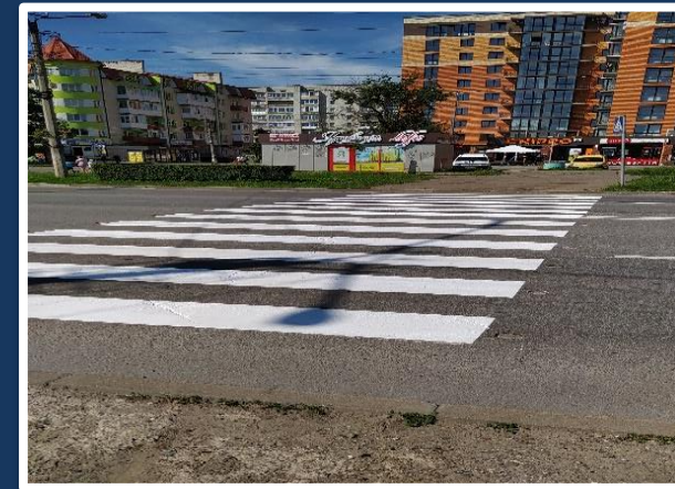
Нанесення та відновлення дорожньої розмітки
