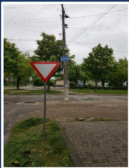
Встановлення дорожніх знаків
